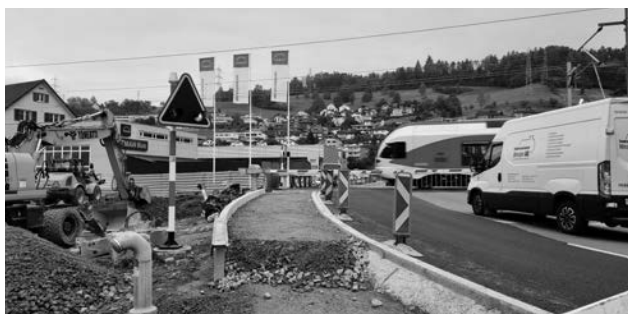
Neues Trottoir beim Bahnübergang Allmeindstrasse
