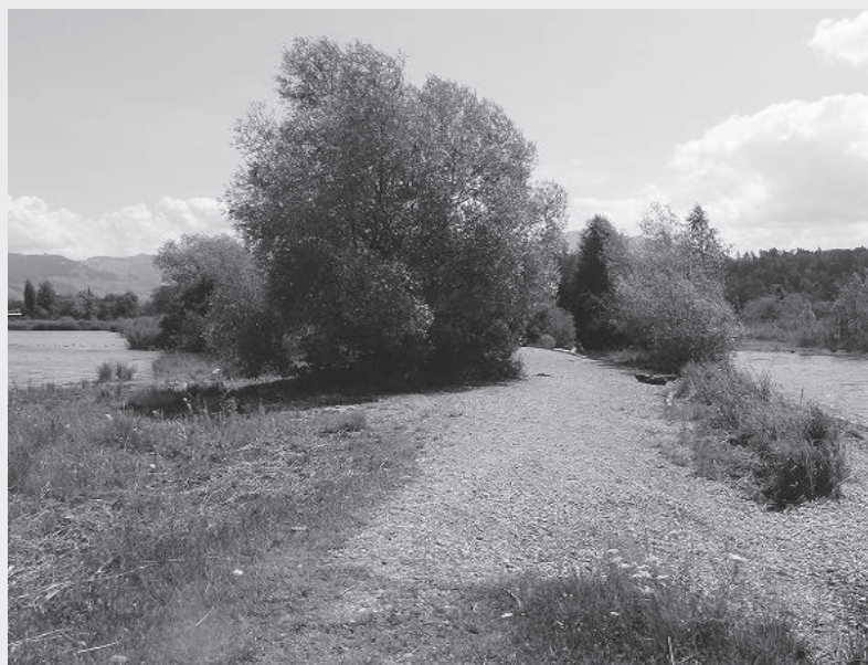
Der rechtsseitige Aabachdamm wächst in den See hinaus
