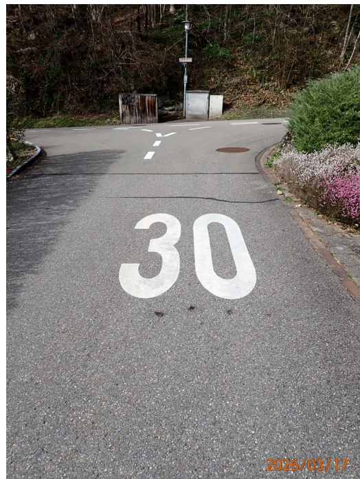
Abb. 5. Einmündung in Spitzestrasse
