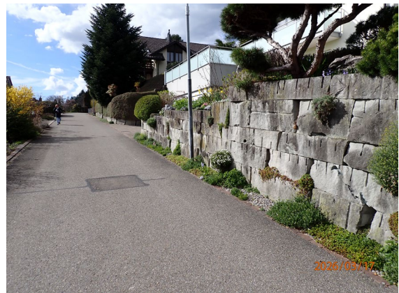
Abb. 3. Seeblickstrasse mit seitlicher Mauer
