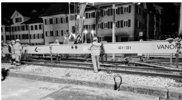
Zur Unterführung des Bahntrasses wurden die Schienen herausgehoben.
