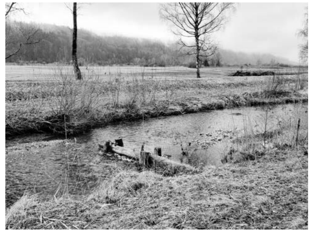
Die Struktureinbauten im Aabach haben sich bewährt
