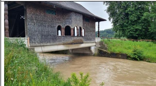
Erneuerte «gedeckte Brücke» mit höherem Freibord.
