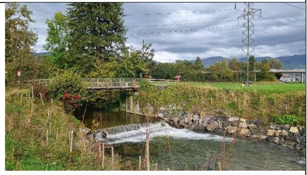
Die Schwelle und die linke Böschung oberhalb der neuen SBB Brücke weisen bauliche Defizite auf, die anlässlich der Wasserbauprojekts Aabach 2. Etappe behoben werden müssen.
